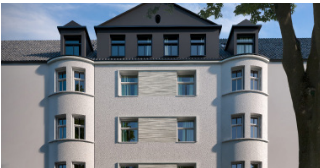
Mehrfamilienhaus Böblingerstraße in Stuttgart | 12 Einheiten
