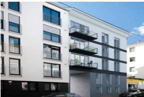
Mehrfamilienhaus Heusteigstraße in Stuttgart, 19 Einheiten
